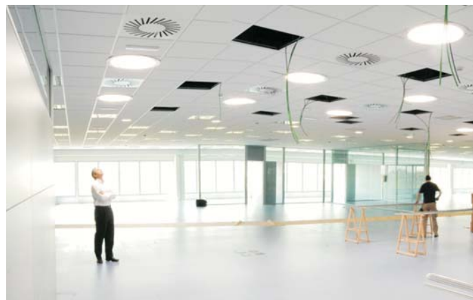
Los tubos de luz de 550 mm de diámetro iluminan una zona de oficinas alejada de las ventanas, ofreciendo una importante conexión al exterior gracias a la luz natural. Los difusores se han diseñado especialmente para permitir un trabajo cómodo con ordenadores evitando deslumbramientos y reflexiones en las pantallas de ordenador.
